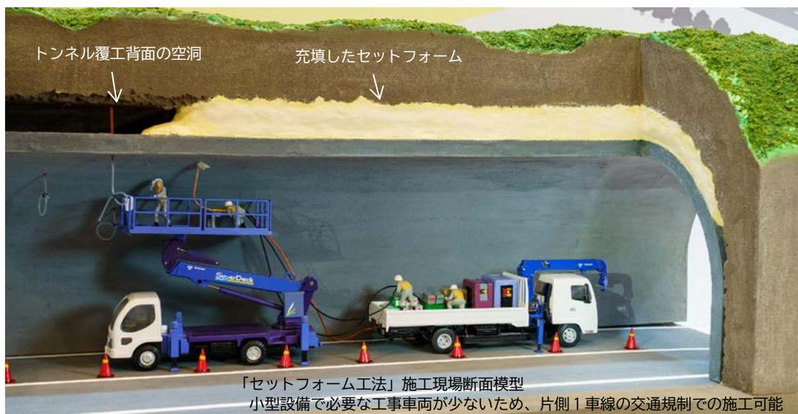
「セットフォーム工法」は、トンネル覆工背面の空洞に硬質ウレタンフォーム「セットフォーム」を充填することにより、トンネル背面の地山を安定化させ崩落事故を防止する補修工法（裏込注入工）です。2012年に発生した「笹子トンネル天井板落下事故」をきっかけに、国内では全てのトンネル点検が義務付けられ、今後ますますその需要は高まっています。これまでは、セメント系注入材が主でしたが、発泡時に発生する温室効果ガスの排出を抑えた安全なノンフロンの硬質ウレタンフォームを開発したことにより、その優位性からも「セットフォーム工法」が評価されています。
